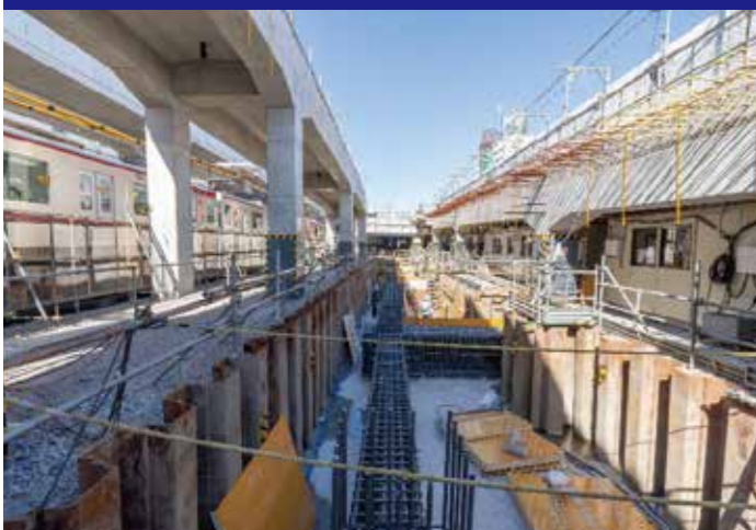
北千住方高架下(基礎工事状況)
