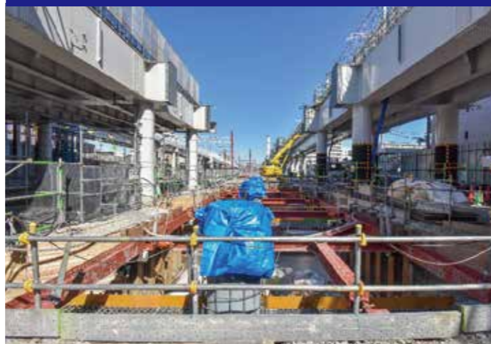
春日部方高架下(基礎工事状況)
