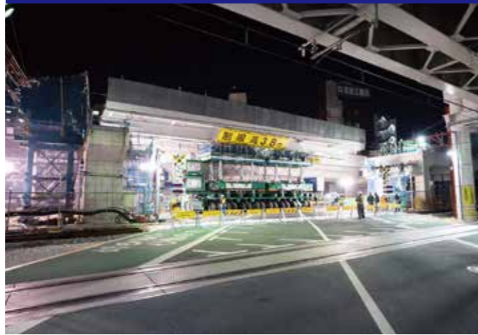
第37号踏切道(桁架設状況)
